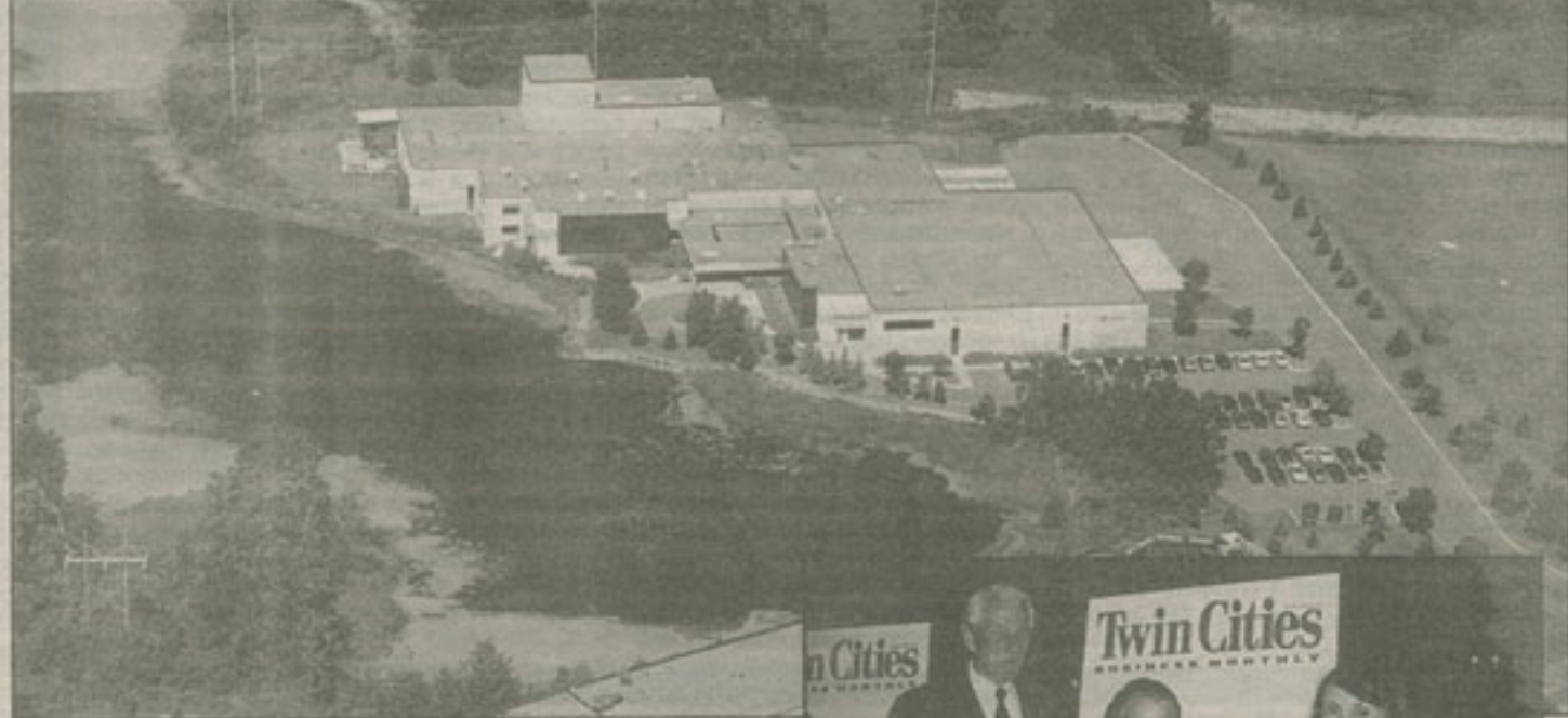
Tvornica Borisa Mikšića nalazi se na zemljištu površine 7.000 kvadratnih metara, a planira se i gradnja dvaju novih, specijaliziranih, zdanja
